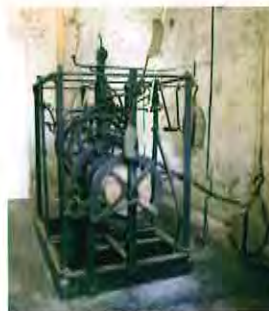
Afb. 3: Het torenuurwerk van Nieuwe Niedorp
