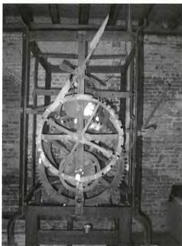
Afb. 3 Dankzij enkele lagen menie heeft de roestduivel nauwelijks vat gehad op het uurwerk.
